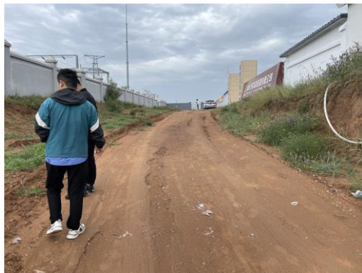
升压站南侧进站道路
