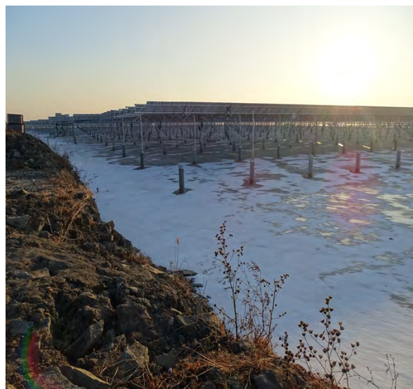
项目区施工中光伏列阵区
