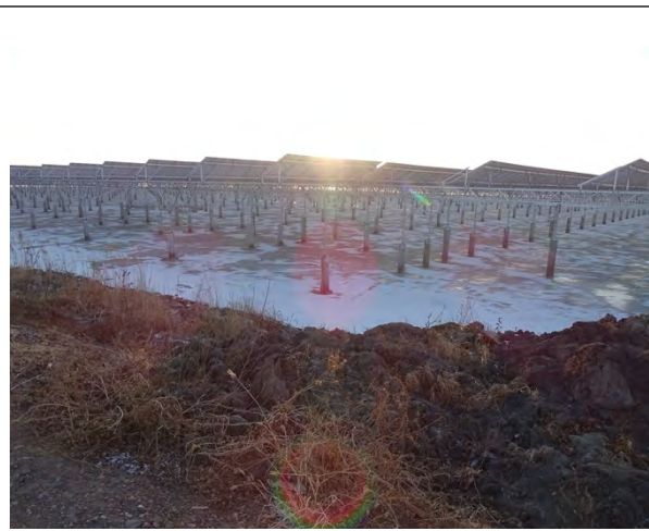
项目区施工中光伏列阵区
