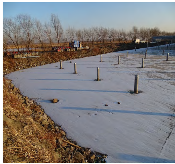
项目区施工中光伏列阵区
