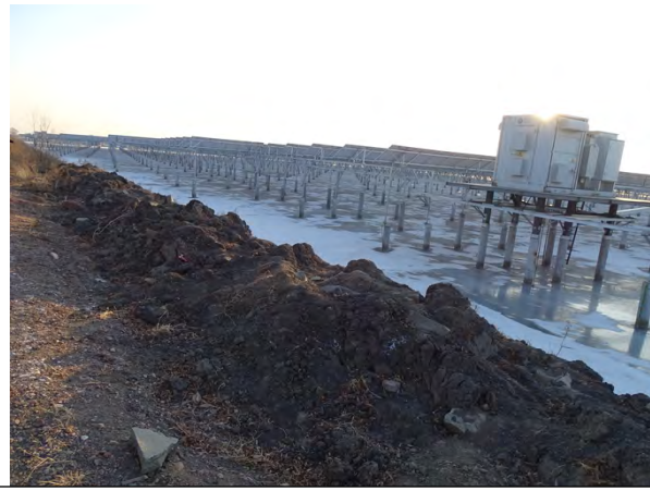
项目区施工中升压站
