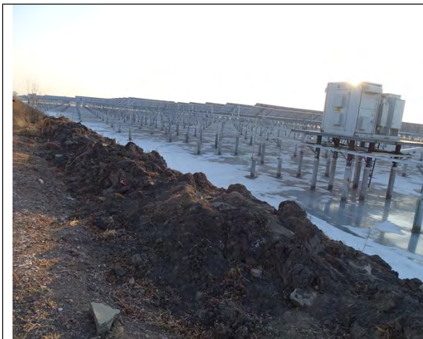
项目区施工中光伏列阵区
