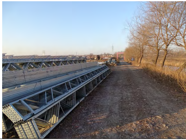
项目区施工中光伏列阵区
