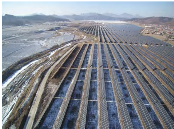
无人机拍摄光伏列阵区
