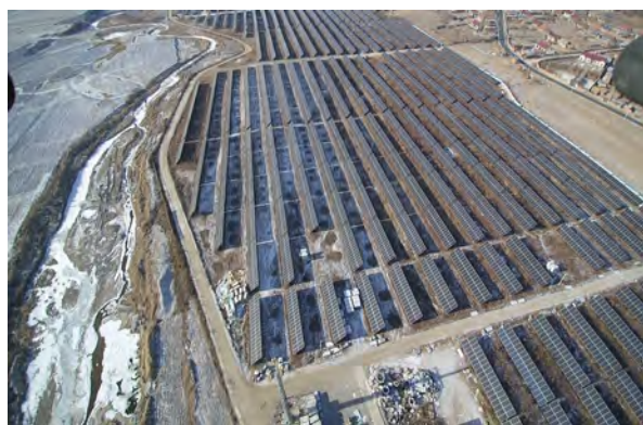
无人机拍摄光伏列阵区
