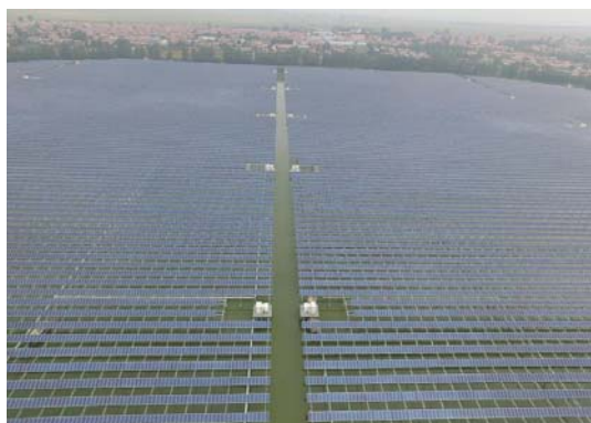
厂区内检修水路
