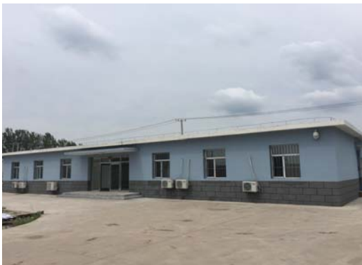
依托生产综合楼
