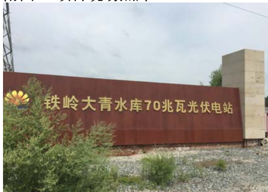
依托 66kV 升压站
