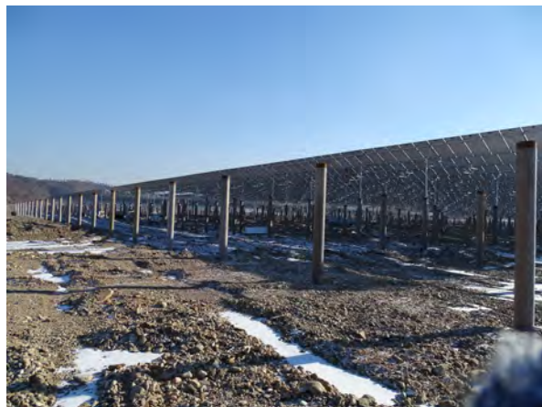
施工中光伏列阵区
