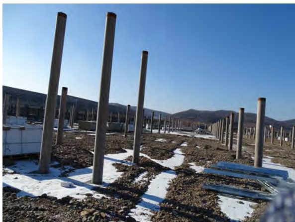
施工中光伏列阵区
