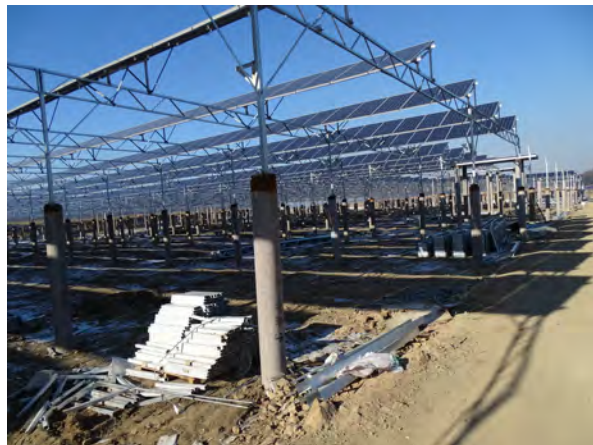
施工中光伏列阵区
