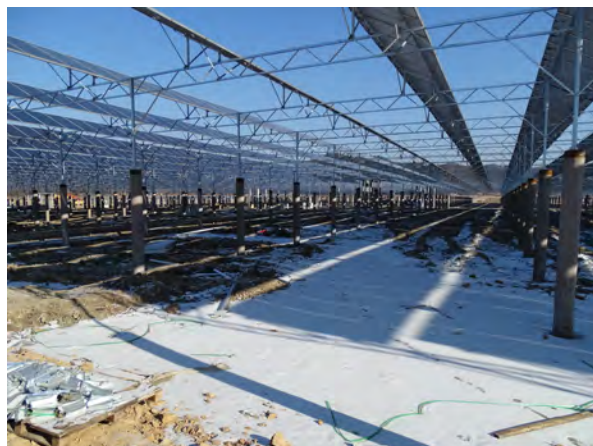
施工中光伏列阵区
