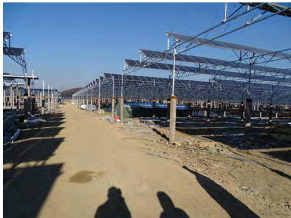
施工中光伏列阵区
