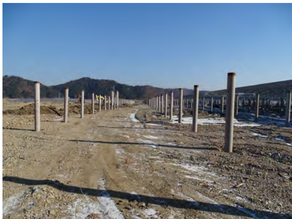
施工中光伏列阵区
